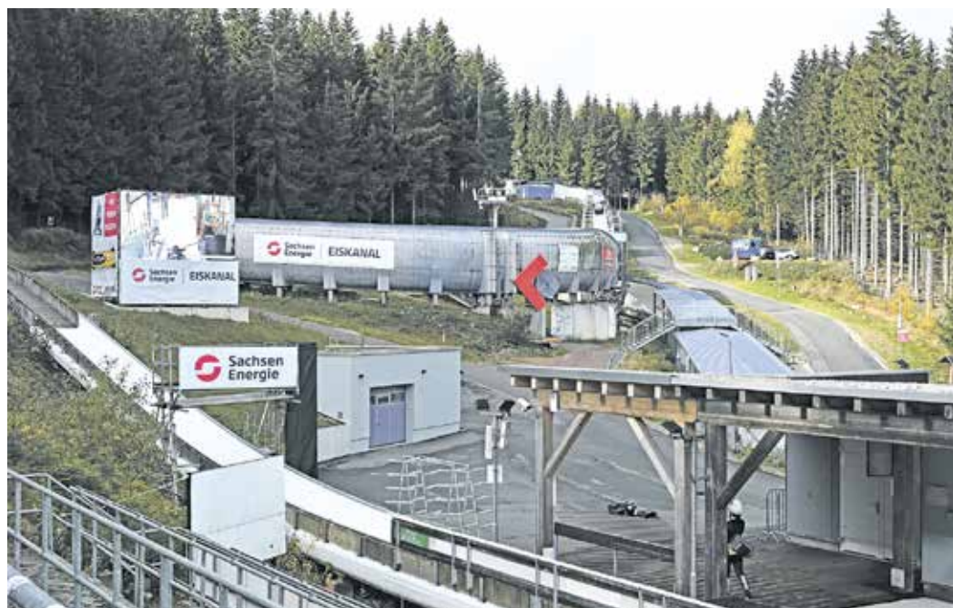
Auch die Rennschlitten- und Bobbahn Altenberg erhielt Fördergelder.
