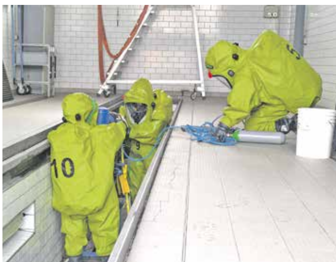
Einsatzkräfte in Chemikalienschutzanzügen sichern ein Leck in der Rohrleitung.
