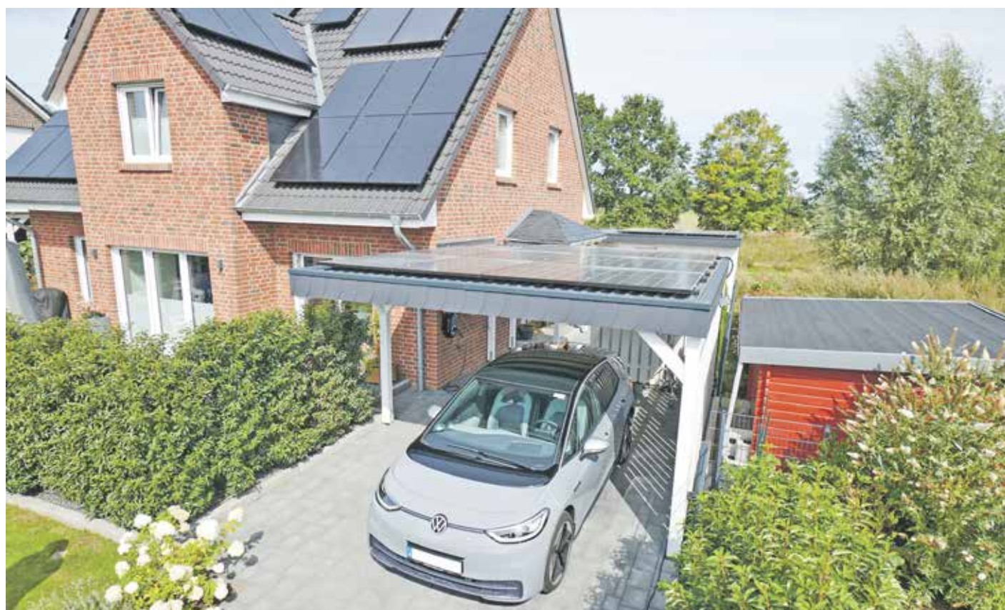
Mehrfacher Nutzen: Der selbst erzeugte Solarstrom kann nicht nur im Haushalt genutzt werden, sondern auch das E-Auto mit Energie versorgen.
